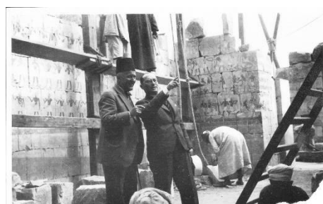
Figure 4 : É. Drioton sur un chantier.
